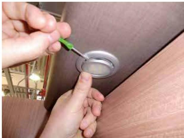
Fig. 52 Sostituzione lampadine sul faretto incassato
